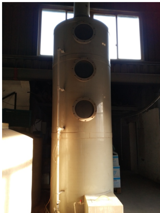
图 3-4 酸洗废气处理装置
