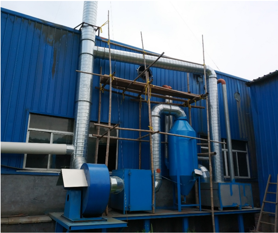
图 3-6 喷塑、固化、柴油燃烧废气处理装置
