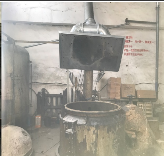
图 3-3 浸漆车间集气罩
